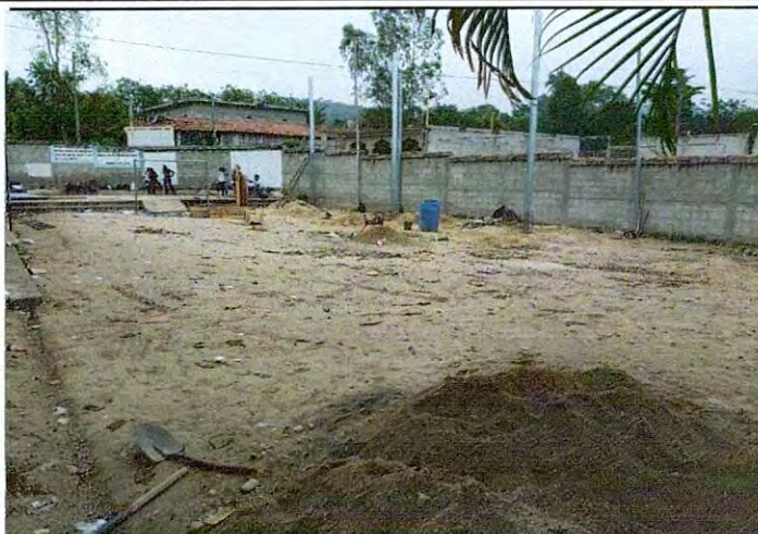
Foto 2: Perfil lateral de las bases de vigas de metal
