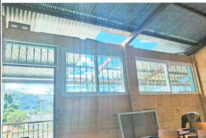
Foto 1: Durante la Instalación de ventanales en el S-5
