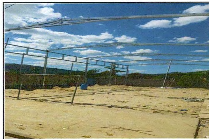
Foto 4: Area de mejoramiento de estructura metalica
