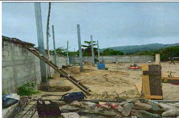
Foto 1: Durante el proceso de fijar las bases de metal.
